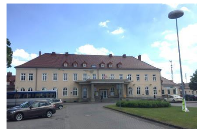
27 Bahnhof, Stettiner Straße 52
